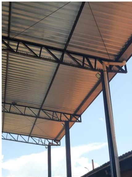
Figura 6: Lateral da quadra, pilares a 5,35m.
