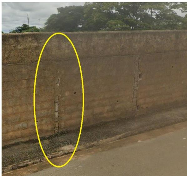
Figura 5: Indicação da ferragem exposta.
